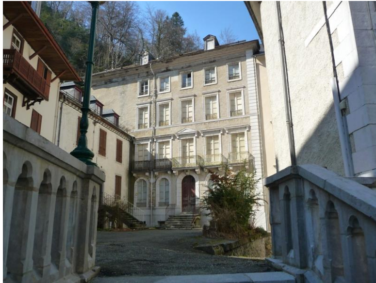
Eaux-Bonnes . La Maison Courtade ; photo de mars 2011 communiquée par la Municipalité
