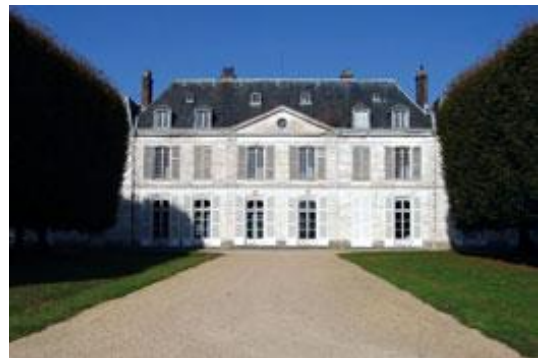
Vue actuelle du château de Millemont ( Photo )
